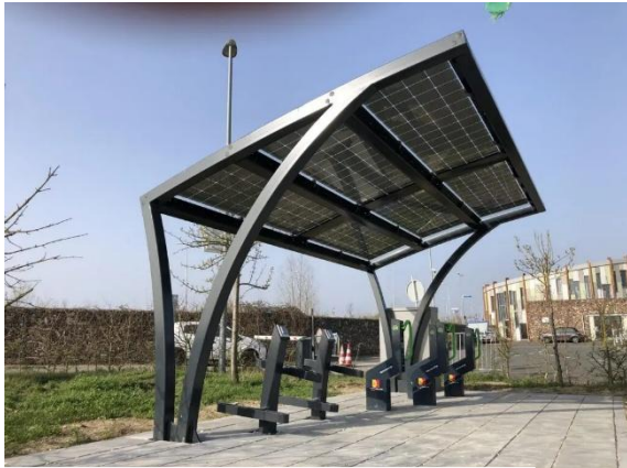
Figuur 53 Fietsenstalling met zonnepanelen
