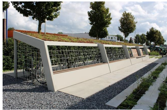
Figuur 52 Fietsenstalling met sedum dak
